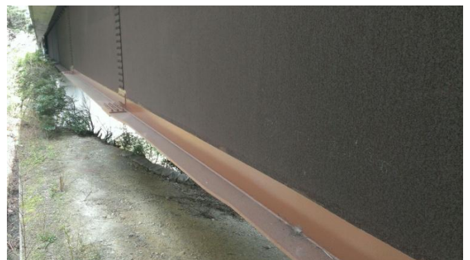
写真-9 下フランジ上面と立上り部の補修塗装
