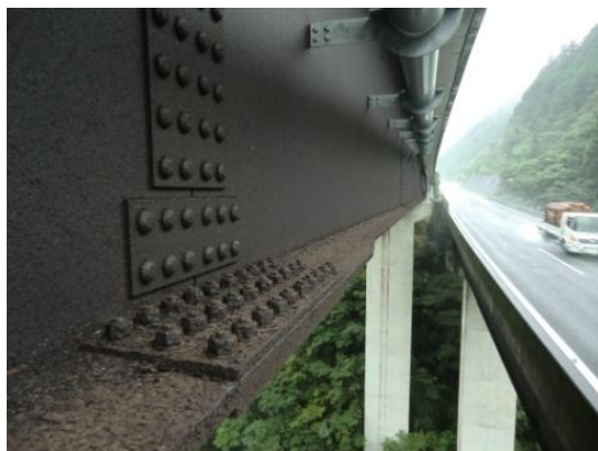
写真-19 高低差のある橋梁の近接状況
