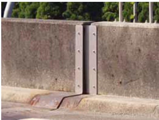
図-24 高欄目地部を塞いだ事例
