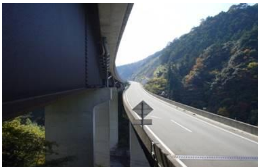
図 4-3 平瀬橋の全景写真
