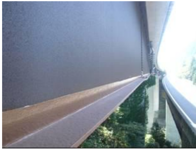
図 4-15 補修塗装後の状況写真
