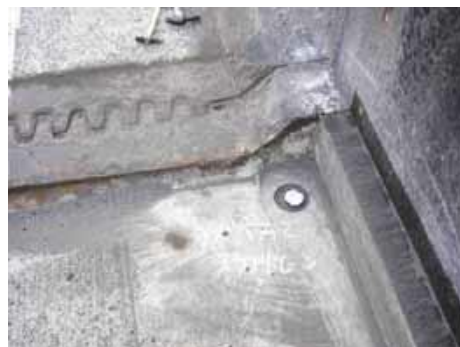
図-20 床版水抜き (設置例)
