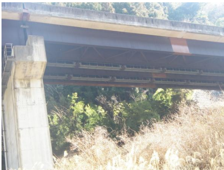
写真-23 補修塗装の現状
