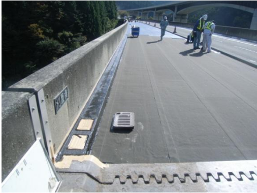
写真-5 橋面防水工
