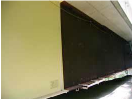
図-26 塗装端部に水切りを設置した事例
