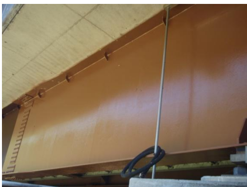
写真-8 外桁の補修塗装（損傷範囲全体の塗装）
