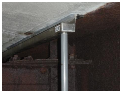
写真-12 水切り対策として樋を設置
