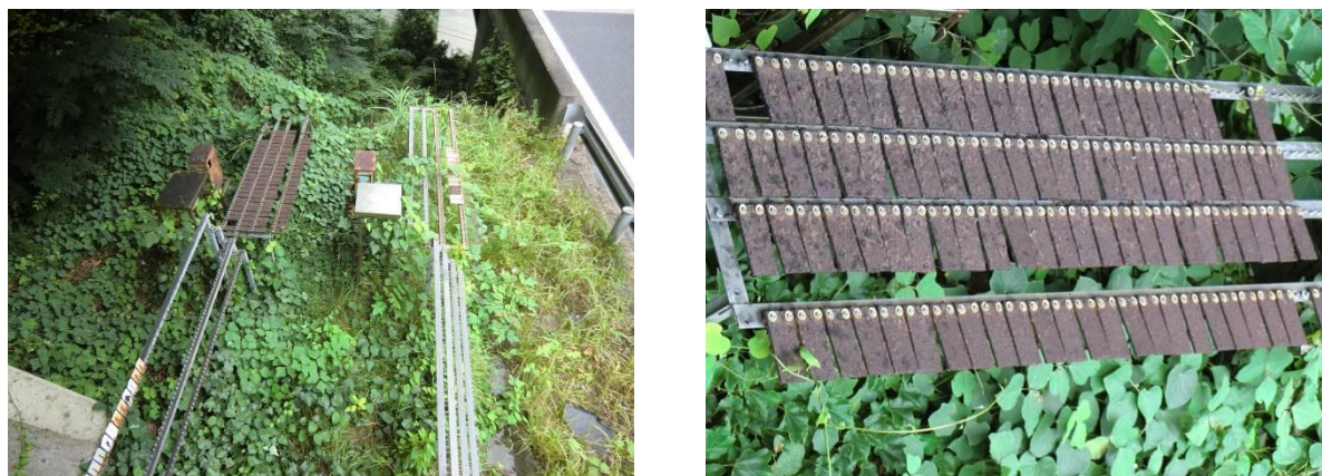
図 4-13 暴露試験片の設置状況
