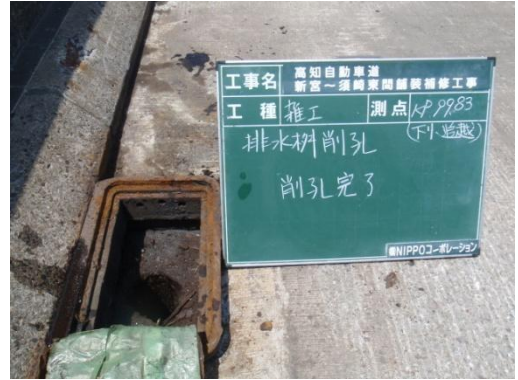
写真-6 排水ますの改良（排水孔の追加）
