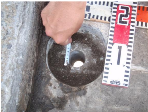
写真-7 床版排水孔の追加
