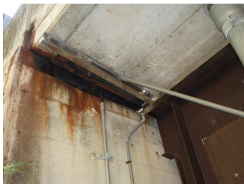
写真-11 漏水対策として樋・導水管の設置
