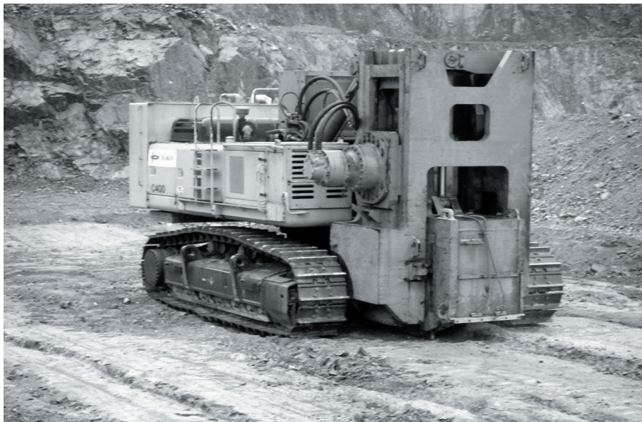
写真1 センターカッターユニットによる切削状況
