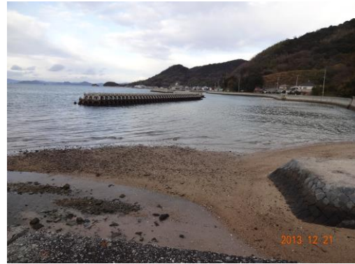
写真20 引野地区海岸 (2013年12月22日, 寺谷撮影, 上弓削方面を望む)
