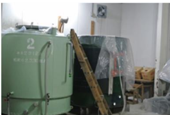
写真7 板野酒造場の仕込みタンク (2016. 9. 14. 寺岡撮影)
