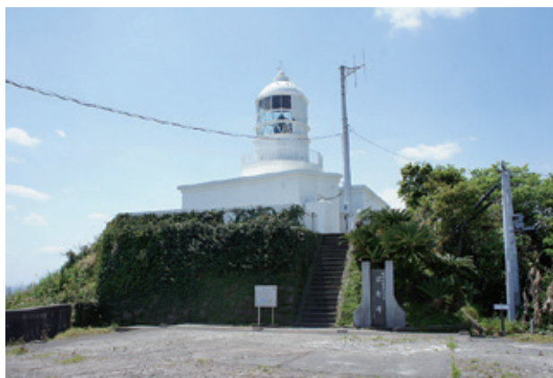
写真1：日本初の無筋コンクリート製の鞍埼灯台
