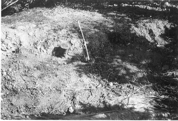
図-6 地すべりによる亀裂と陥没，約80cmの落差 (八幡浜市川上町白石)
