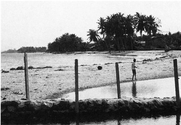
Fig. 11 Severe coastal erosion seen at the coast of Ta Sala. 第11図 タサラの海岸における突堤下手側の海岸侵食
