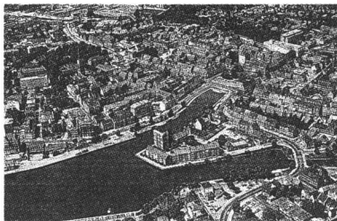
Emden. Stadtzentrum (Luftbild)
