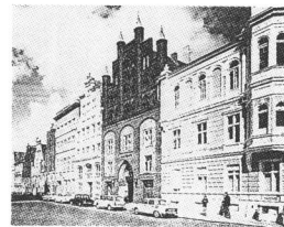
Stralsund. Restaurierte Bürgerhäuser am Alten Markt
