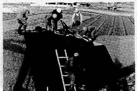
写真-10 防水シート敷設 (3号田)
