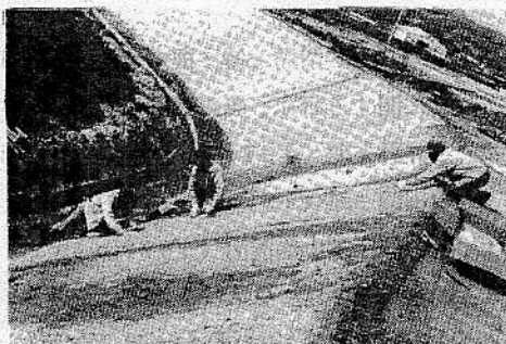
写真-14 植生マット工法 (4号田)
