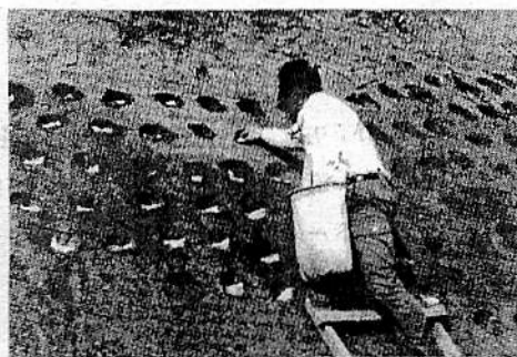
写真-16 穿工植生工法
