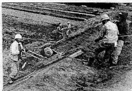
写真-11 法面の鎮圧 (4号田)
