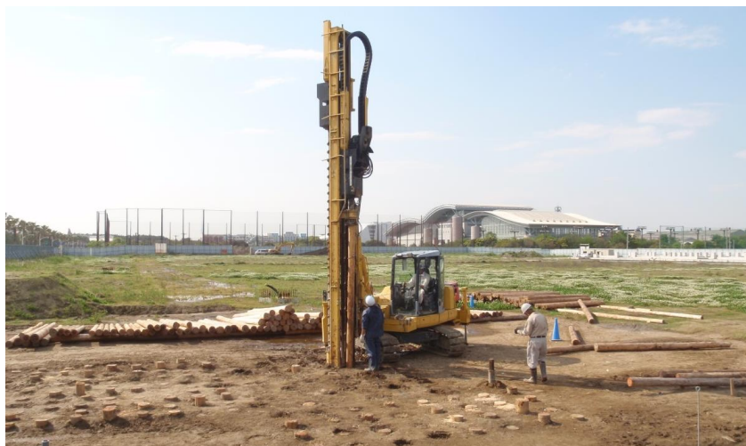
写真-1 丸太による液状化対策工法の施工全景（千葉県浦安市内、2014年11月7日撮影）
