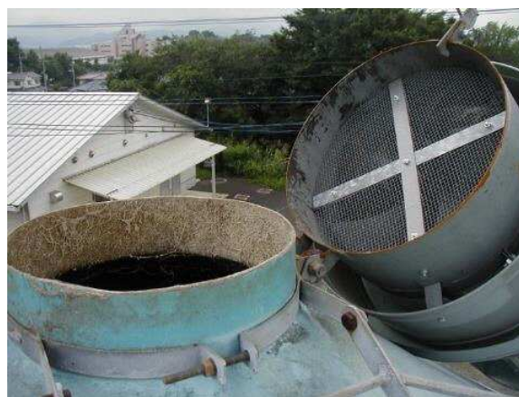
写真 2 通常の飼料タンクの蓋と同様に開閉可能な換気式蓋
