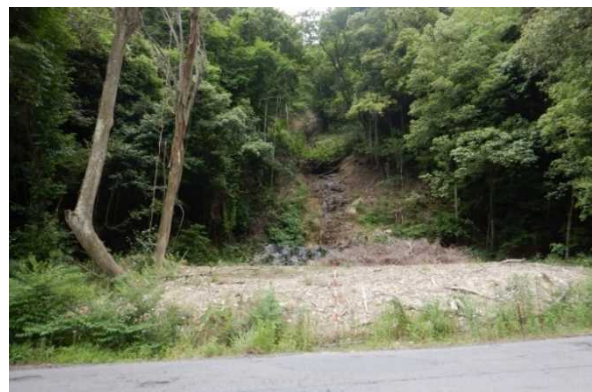
写真-3.4.11 谷出口に残置された流出土砂
