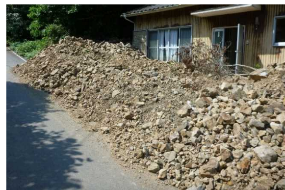
写真-3.4.2 B・C の流出土砂による被災状況
