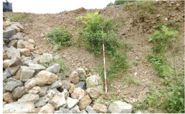
写真-3.4.7 緩傾斜地に集積された流出土砂
