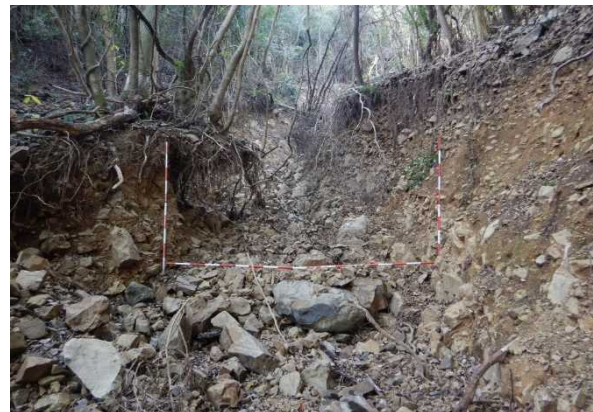
写真-3.4.6 0次谷Bの溪岸の侵食状況
