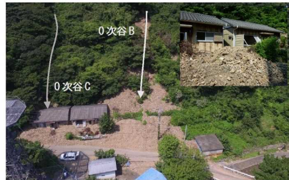
図-3.2.2 大月町橋浦での被災状況
