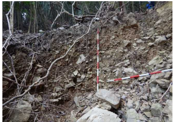
写真-3.4.4 0次谷B 溪岸の土砂層
