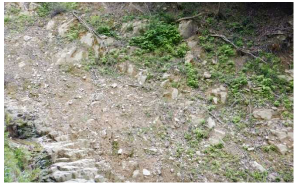
写真-3.4.12 0次谷⑧の溪岸に露出する土砂
